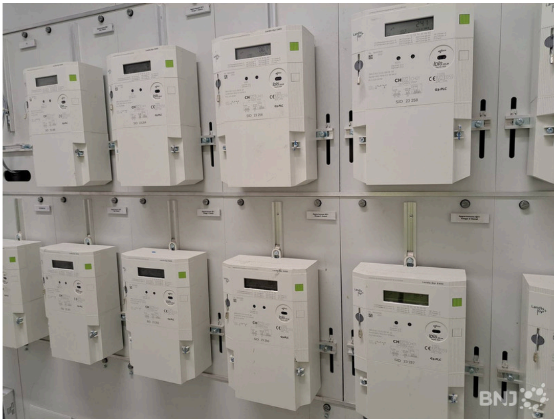
Ces compteurs "intelligents" seront utilisés par l'étude "Infineed" pour évaluer les habitudes de consommation des ménages participants. (Photo : Services industriels de Delémont)
